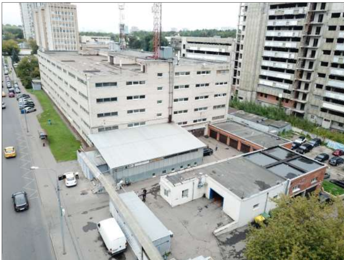
Фото 1. Общий вид Объекта экспертизы.
