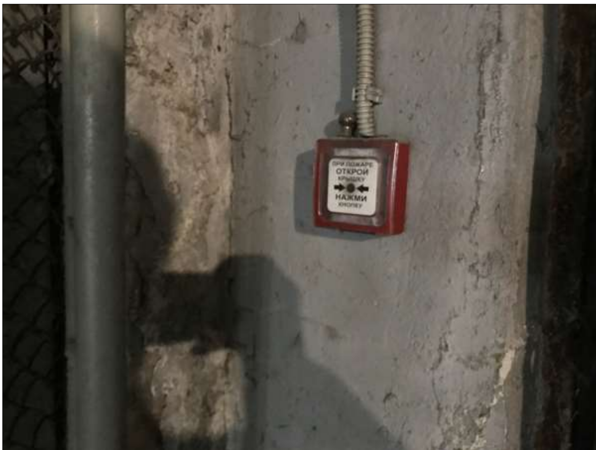
Фото 9. Ручной пожарный извещатель.
