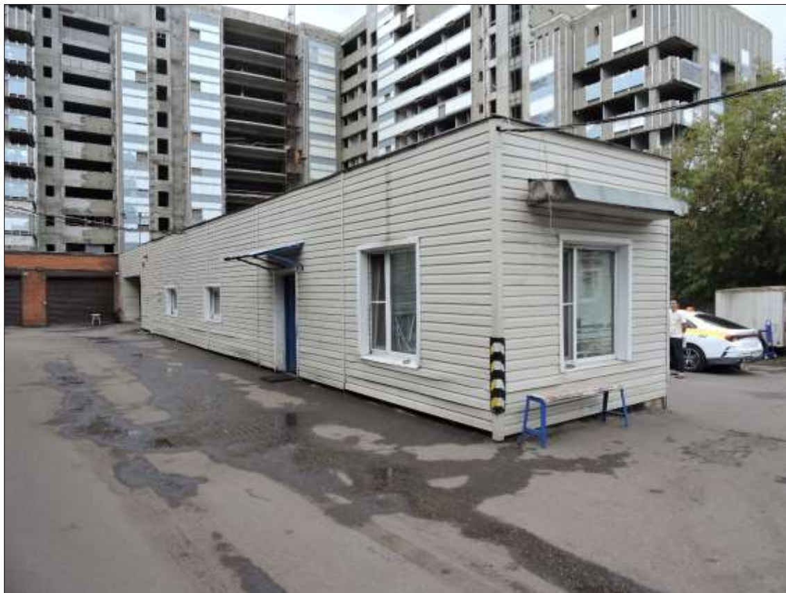
Фото 2. Общий вид Объекта экспертизы.
