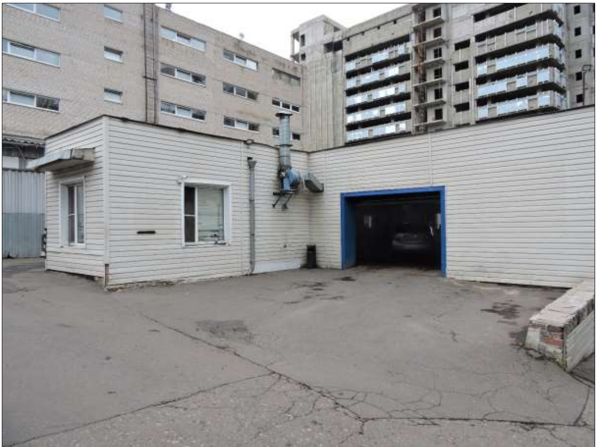
Фото 3. Общий вид Объекта экспертизы.
