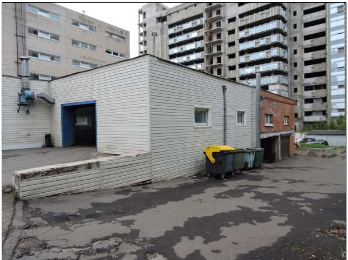
Фото 4. Общий вид Объекта экспертизы.
