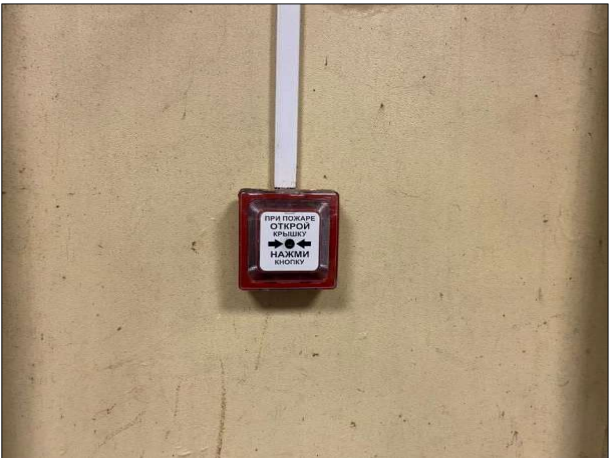
Фото 8. Ручной пожарный извещатель Объекта экспертизы.
