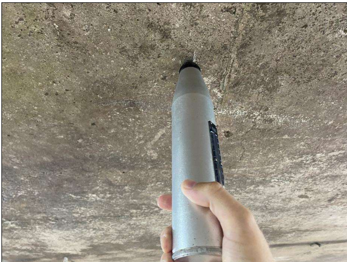
Фото 10. Определение прочностных параметров бетона железобетонной плиты покрытия методом упруго отскока.
