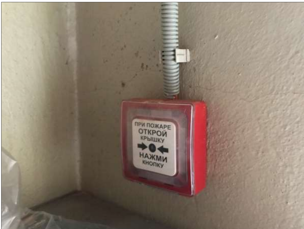
Фото 7. Ручной пожарный извещатель.
