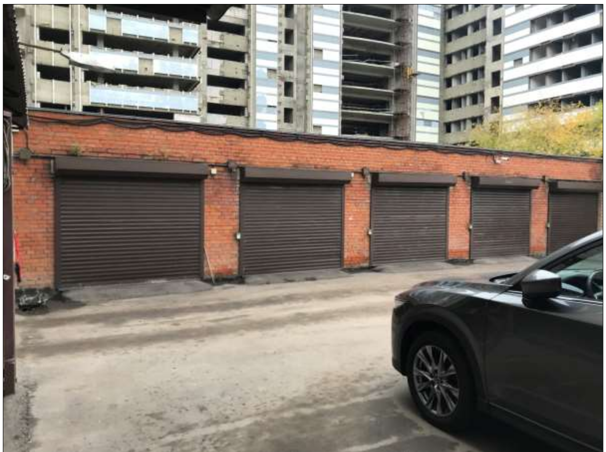
Фото 4. Общий вид Объекта экспертизы.
