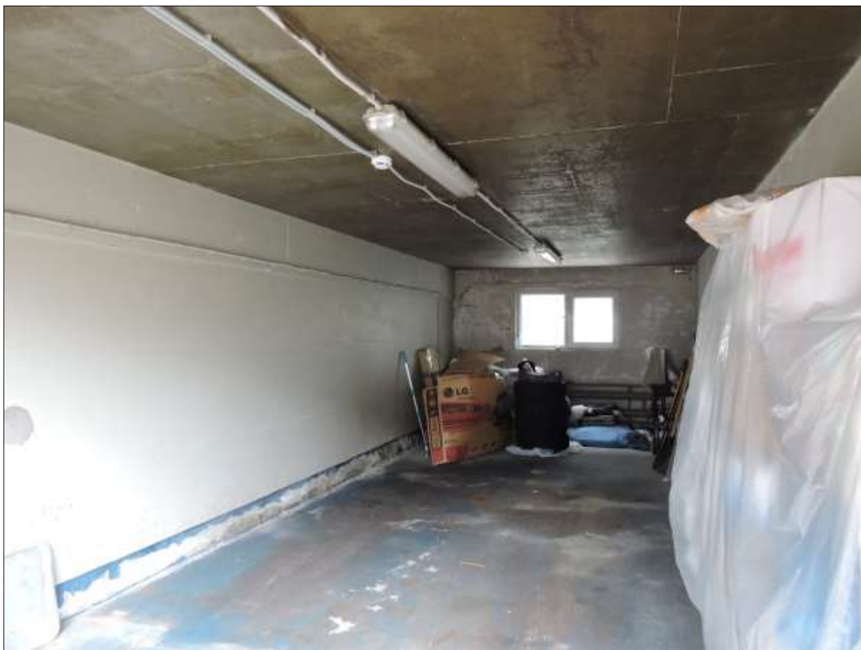
Фото 5. Общий вид помещения (бокса) Объекта экспертизы.
