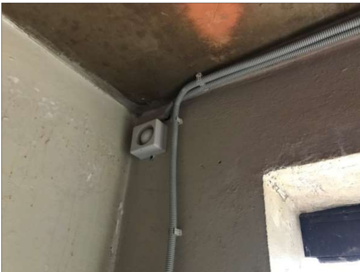
Фото 8. Звуковой оповещатель.
