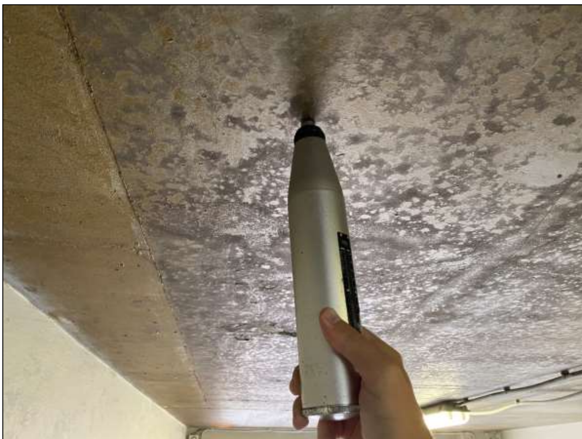
Фото 9. Определение прочностных параметров монолитной железобетонной плиты покрытия методом упругого отскока.
