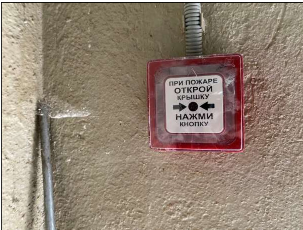
Фото 6. Ручной пожарный извещатель Объекта экспертизы.
