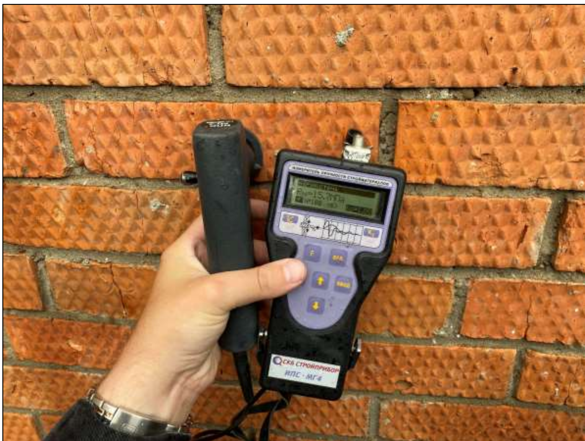
Фото 8. Определение прочностных параметров кирпичной кладки методом ударного импульса.
