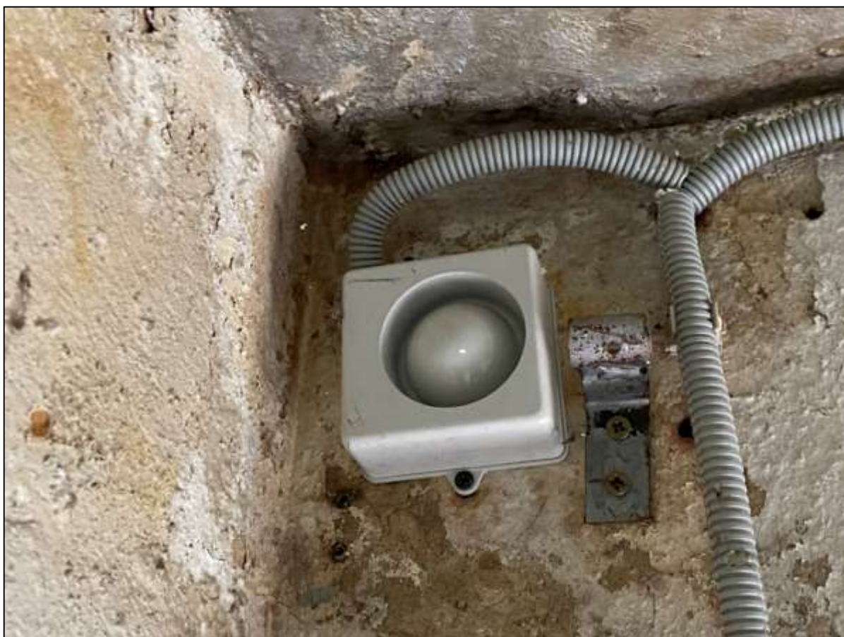
Фото 7. Звуковой пожарный извещатель Объекта экспертизы.
